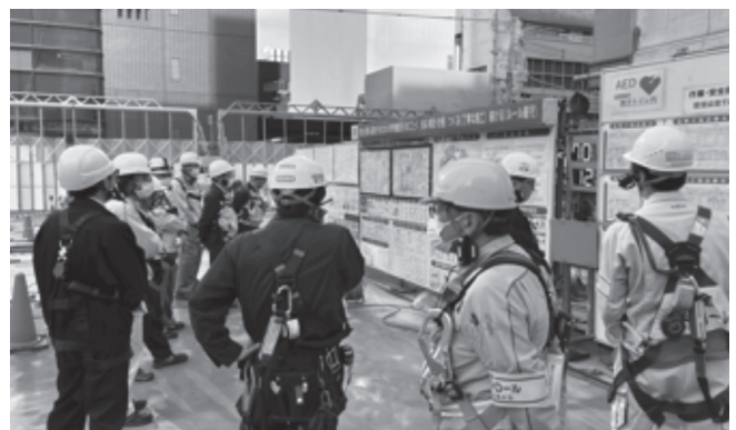
オフィスビル新築工事 (中区)
