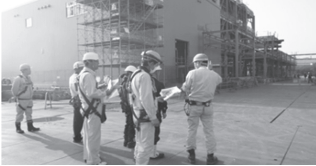
発電所建設工事
