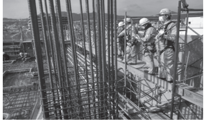
マンション新築工事 (西区)
