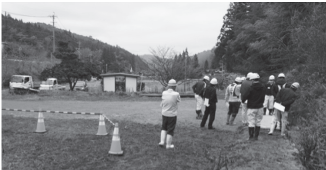
本村川災害復旧工事
