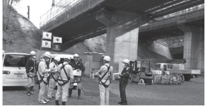
道路改良工事
