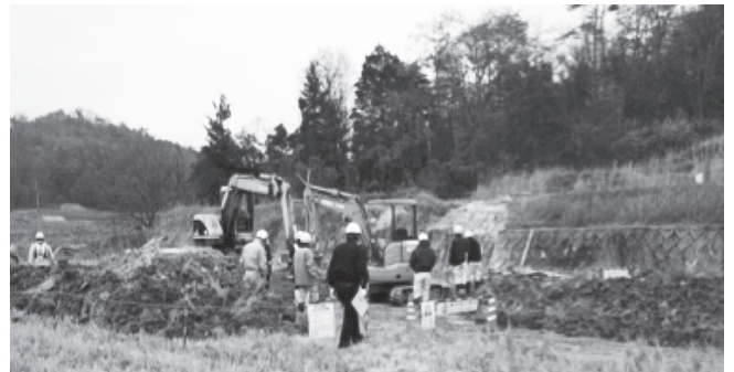
中野農地災害復旧工事
