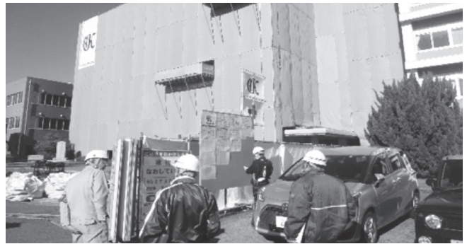
広島商船流通情報工学科校舎改修工事
