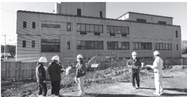
佐伯消防署整備工事
