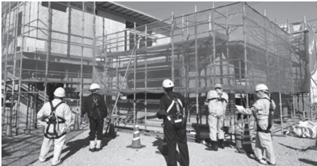
グループホーム棟建設工事
