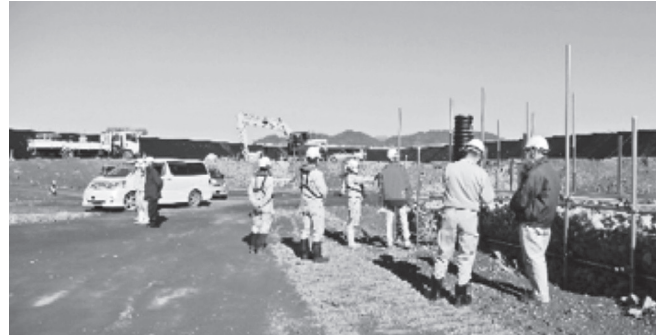
下黒島最終処分場工事
