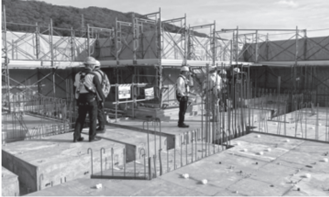
マンション設新築工事 (東区)
