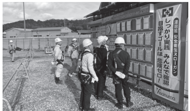
マンション新築工事 (東広島市)
