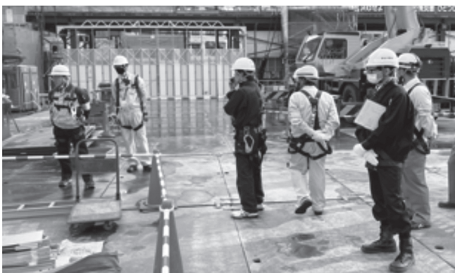
オフィスビル新築工事 (中区)
