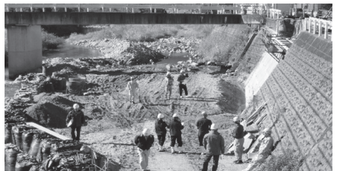
県道本多田佐伯線災害復旧工事
