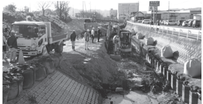
雨水幹線築造工事
