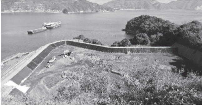
下黒島最終処分場工事
