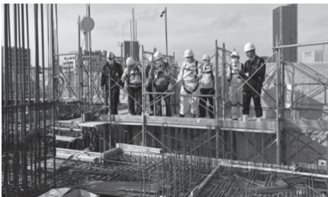
マンション新築工事 (南区)
